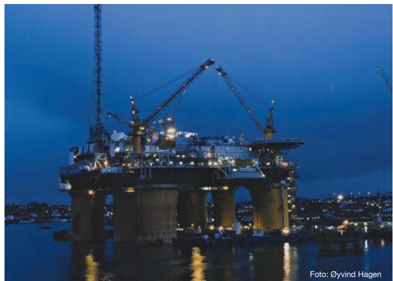
Foto: Øyvind Hagen
