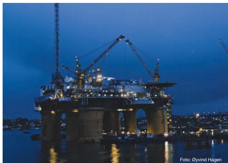
Foto: Øyvind Hagen
